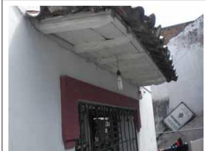
*Figura 54: Vista del detalle de alero con guarda polvos*
