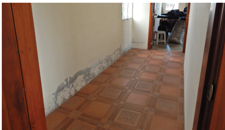
Figura 46. Pasillo segundo piso
