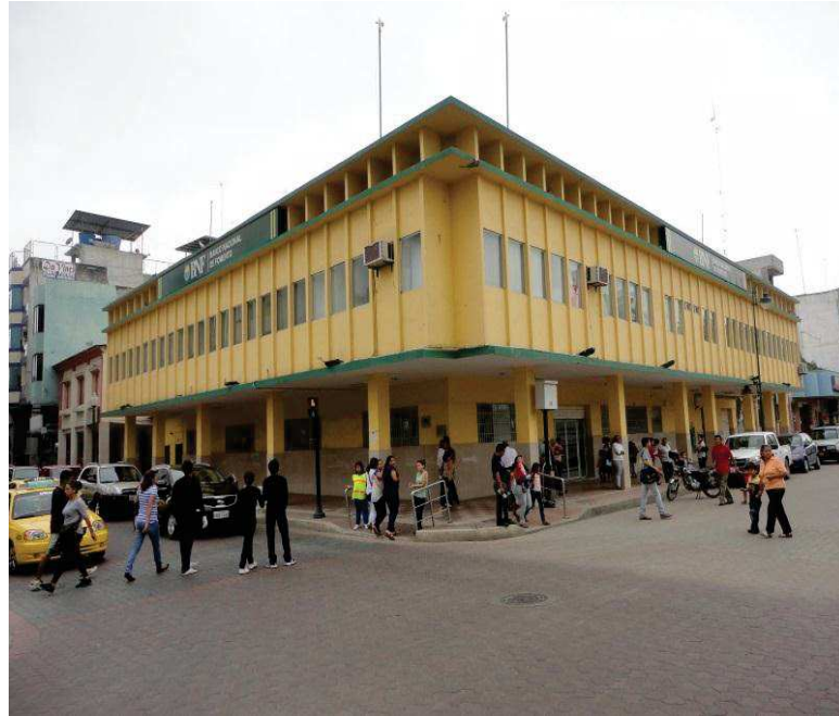
Figura 7. Fachada Exterior del Edificio
