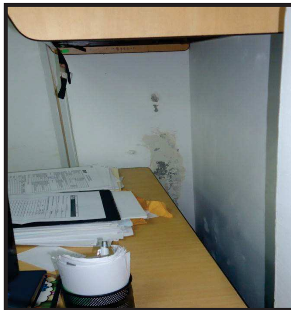
Figura 35. Interior Planta Baja
