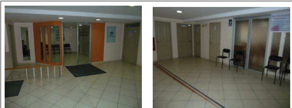
Figura 7. Sub-suelo Clínica El Batán.
