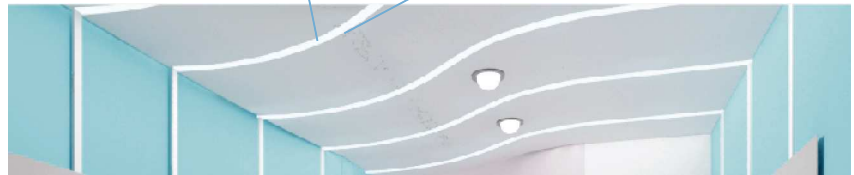
CIELO RASO NEONATOLOGÍA
