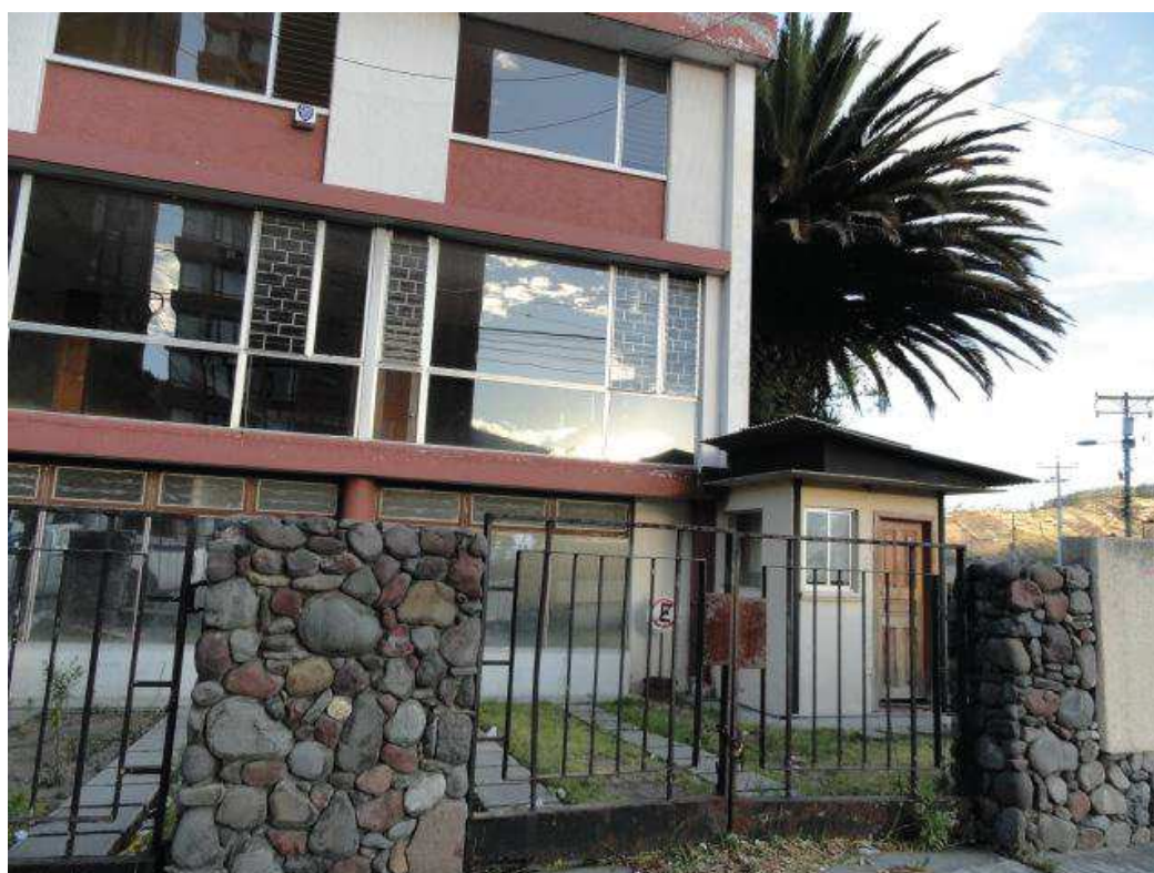
Figura 4. Vista frontal de Edificación. Av. González Suárez, Quito.
