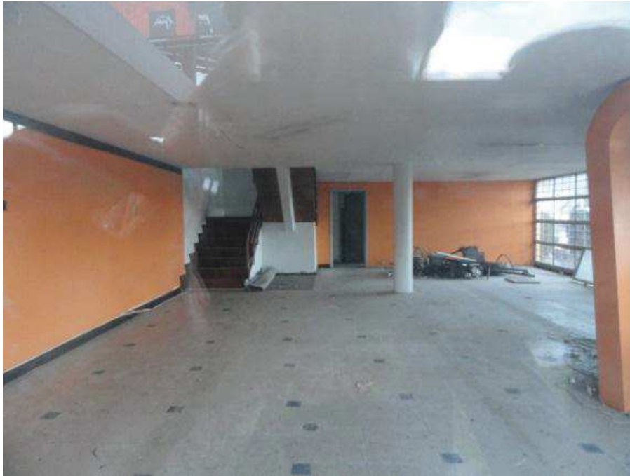
Figura 7. Vista Interior Planta Baja de Edificación. Av. González Suárez, Quito.
