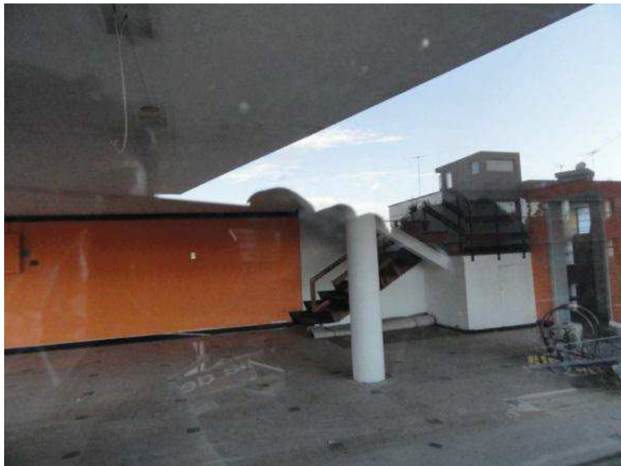
Figura 8. Vista Interior Planta Baja de Edificación. Av. González Suárez, Quito.
