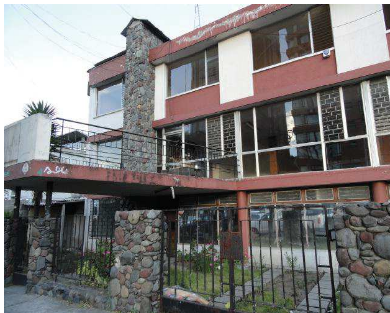
Figura 3. Vista frontal de Edificación. Av. González Suárez, Quito.
