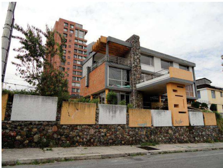
Figura 63. Vista Posterior de Edificación Calle J. Guerrero, Quito.
