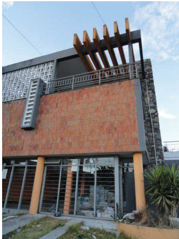
Figura 6. Vista Lateral Der. de edificación. Av. González Suárez, Quito.
