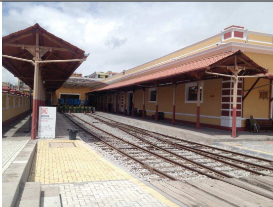
Figura #116. Parada de tren vista exterior
