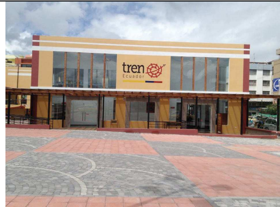
Figura #115. Edificio de oficinas
