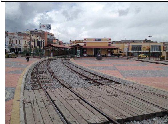
Figura #112. Vista general con rieles.
