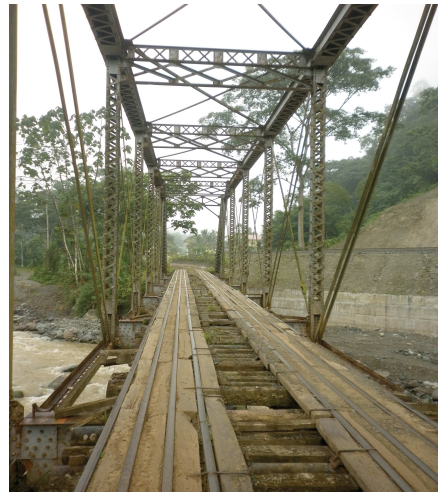
Figura #2. Ingreso a la hostería por uno de los puentes
