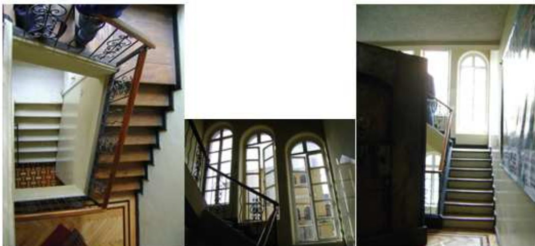
Figura 13. Gradas del bloque principal y sus ventanas.
