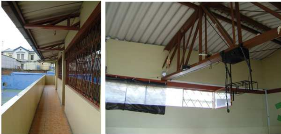
Figura 60. Sistema constructivo metálico en Planta Alta del segundo bloque.
