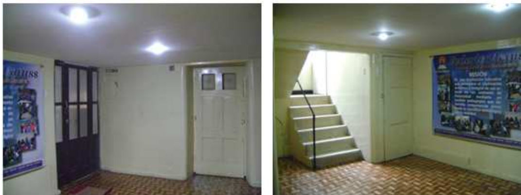
Figura 16. Pasillos del bloque principal.
