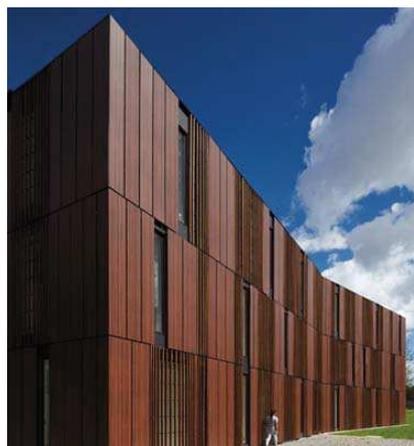
Figura 31: Panelex en fachada
