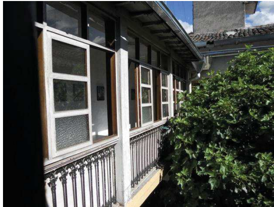
Figura 49. Mamparas Agregadas Anteriormente
