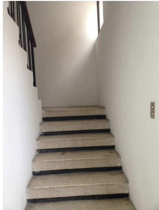
Figura 9. Acceso a planta alta.
