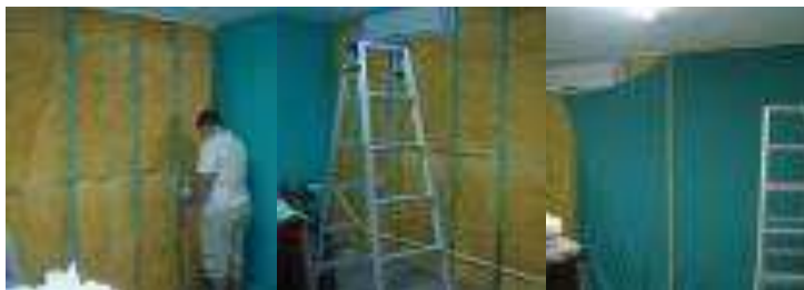
Figura 62. Instalación de revestimientos acústicos en paredes.
