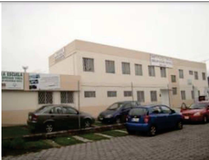
Figura 47. Fachada Frontal Bloque Principal, INSFIDIM.
