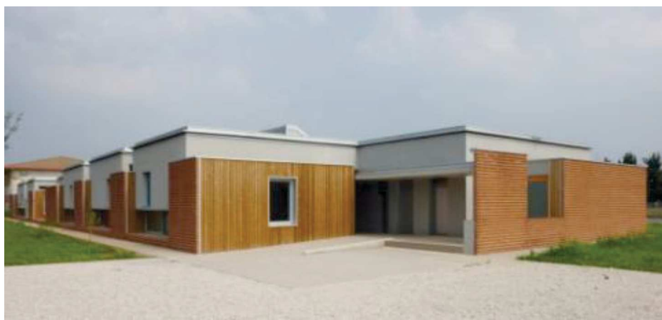
Figura 35. Escuela fossalunga Exteriores.
