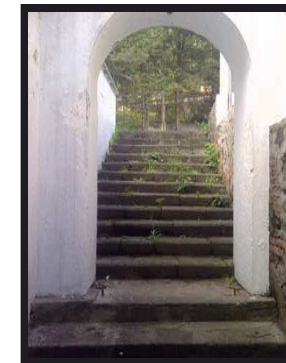
Figura 19. Ingreso principal a la Casa
