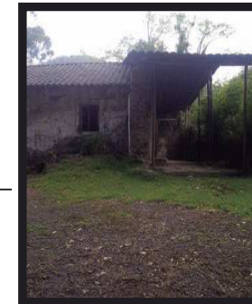
Figura 11. Parte Posterior de la Casa de Hacienda
