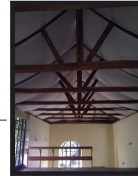
Figura 32. Elementos del mezanine
