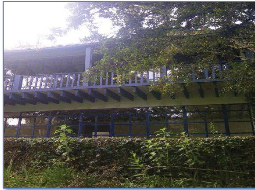
Figura 125. Exterior Casa de Hacienda
