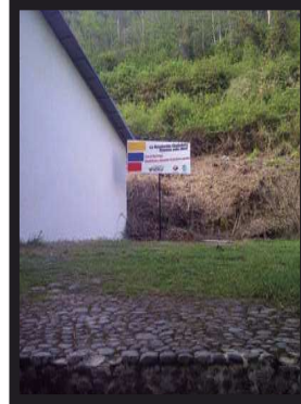
Figura 64. Exterior del Establo
