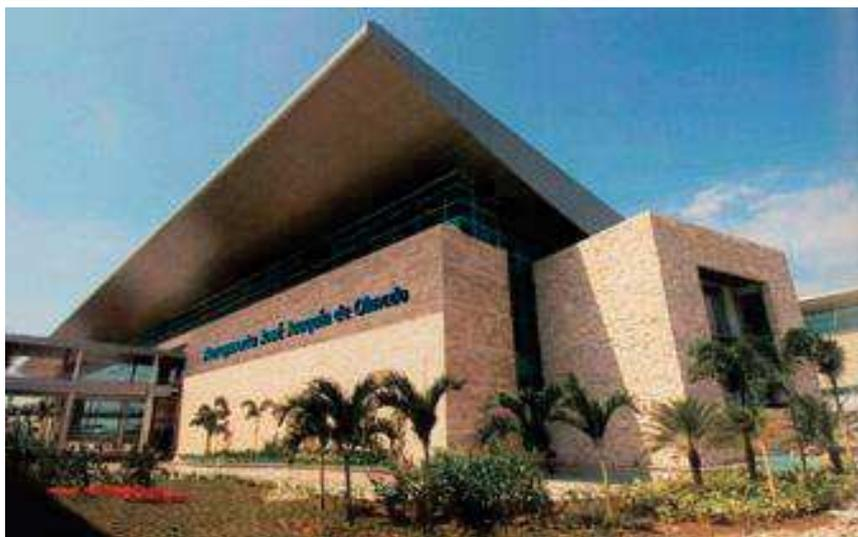
*Figura 13. Una perspectiva de la terminal aérea José Joaquín Olmedo desde una de las zonas del parqueadero, con un revestimiento de piedra con la combinación del metal en su esplendorosa cubierta inclinada.*
