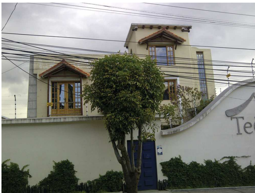
Figura 4. Exterior de la edificación.
