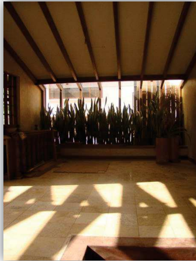
Figura 64: Techo cerchado de madera
