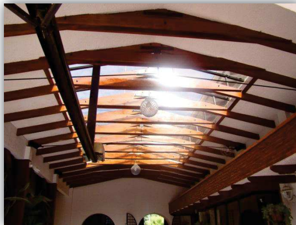
Figura 63: Techo cerchado de madera
