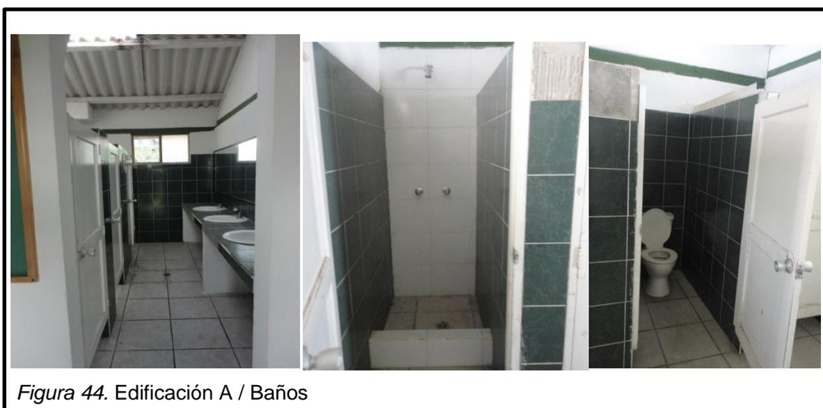
El techo es de eternit con una estructura de madera como soporte. Se utiliza iluminación fluorescente. Las vigas de madera no están en buen estado debido a la antigüedad, se puede observar que algunas de las vigas están pandeadas.
