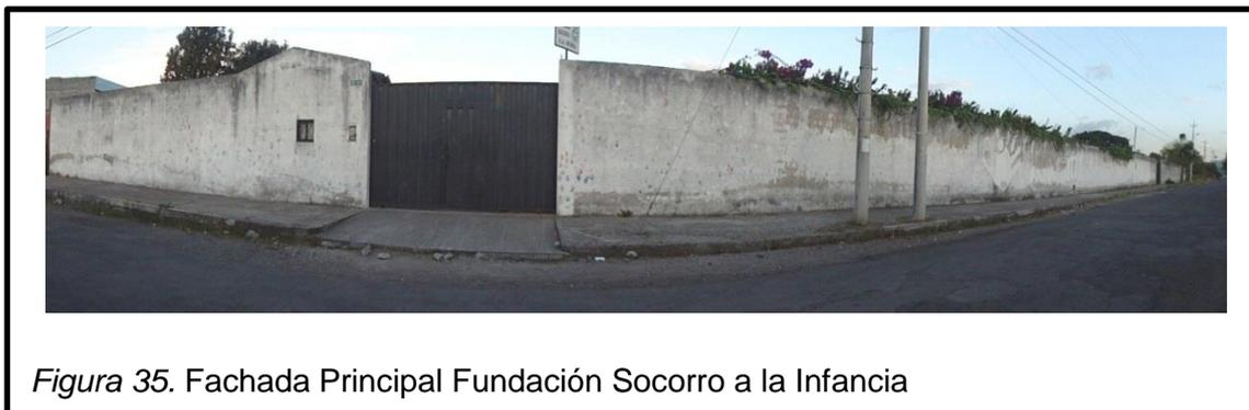
La fachada frontal del terreno se encuentra en un estado de deterioro, no ha tendido ningún mantenimiento, se observa que esta desgastada por la humedad. Se tiene solo ingreso, dado por una puerta de metal, esta sirve para el ingreso peatonal y vehicular.
