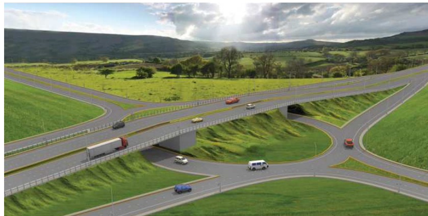
Figura 8 Ruta Viva Intercambiador y escalón Lumbisí
