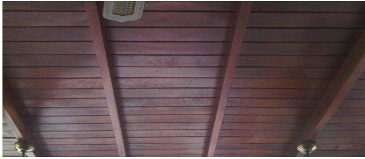
Figura 25. Cubierta de madera en la ampliacion del restaurante.
