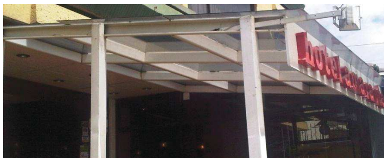
Figura 27. Cubierta del acceso principal del hotel.
