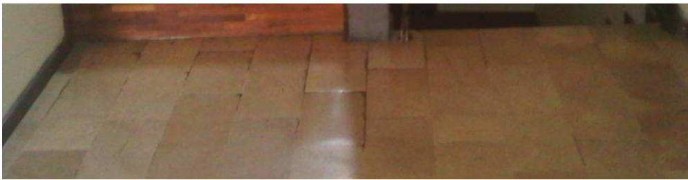
Figura 44. Piso de marmol de la planta baja
