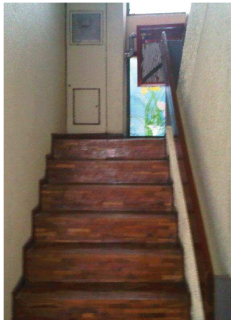
Figura 29. Circulacion Horizontal - Escaleras.
