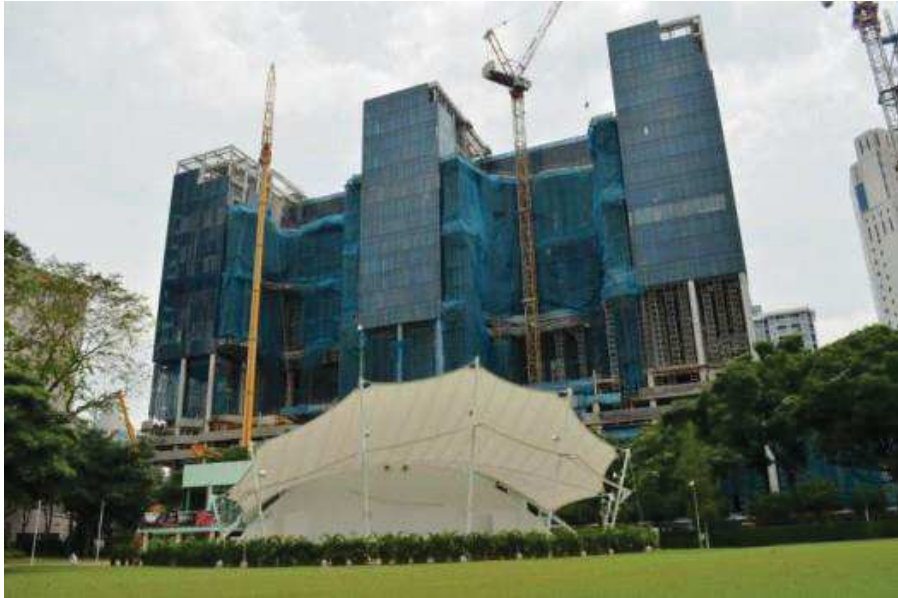
Figura 15. Actualmente en Construcción
