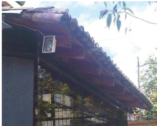
Figura 26. Cubierta de la ampliacion hacia el exterior, uso de teja.
