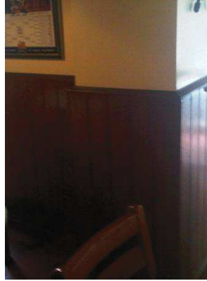
Figura 46. Revestimiento de madera en columnas
