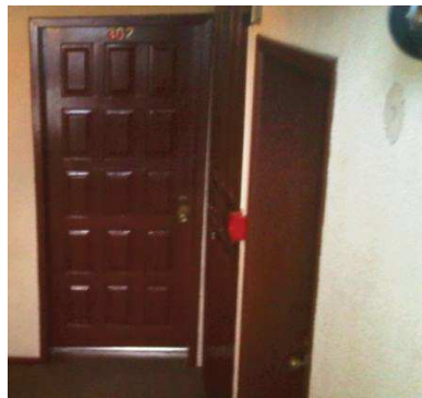
Figura 48. Puertas paneladas de madera.
