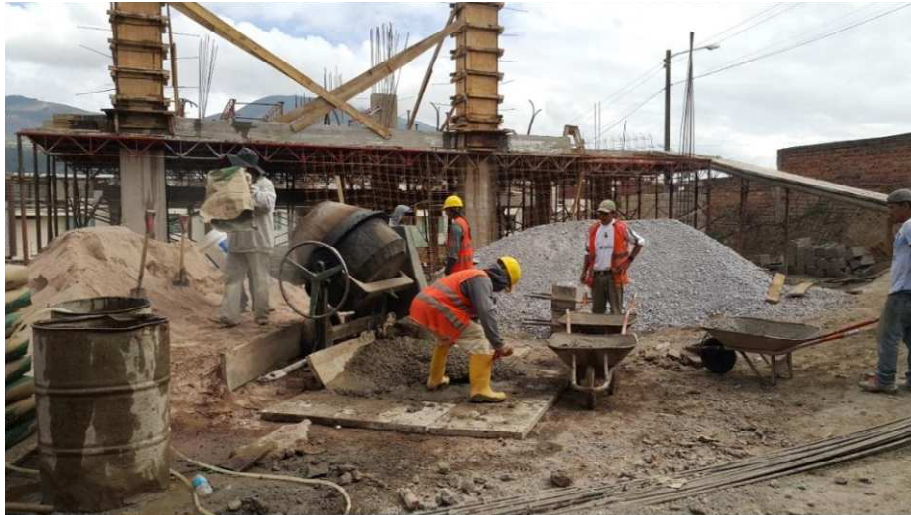
Figura 40: Actividades de preparación Proyecto Villa Fontana Tomado de: Castillo&Cadena Constructora (2014)
