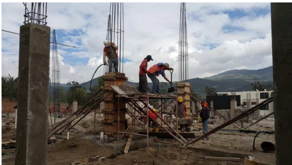
Figura 41: Actividades de transformación Proyecto Villa Fontana Tomado de: Castillo&Cadena Constructora (2014)
