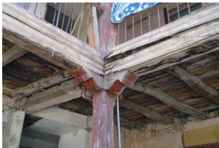
Figura 34. Imagen de columna, montera, soleras, entrepiso
