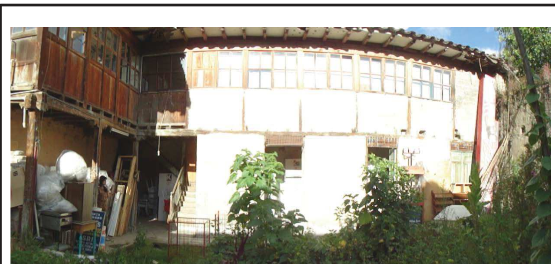
Figura 12. Tercer patio, vista desde otro extremo.
