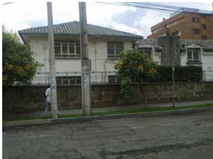
Figura 5. Vista Lateral Derecha, calle Leónidas Plaza Gutiérrez.
