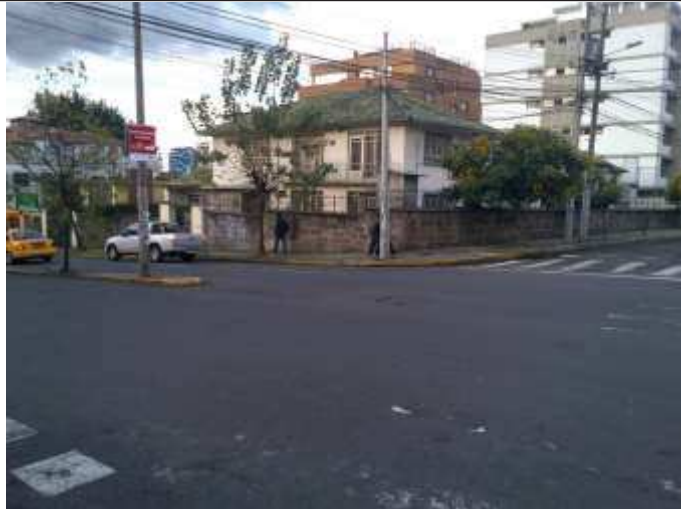
Figura 4. Vista de la casa en la intersección de las calles.
