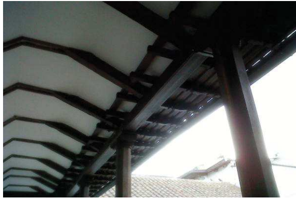
Figura 22. Columnas planta alta
