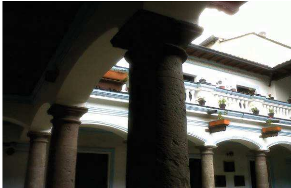
Figura 21. Columnas Planta Baja
