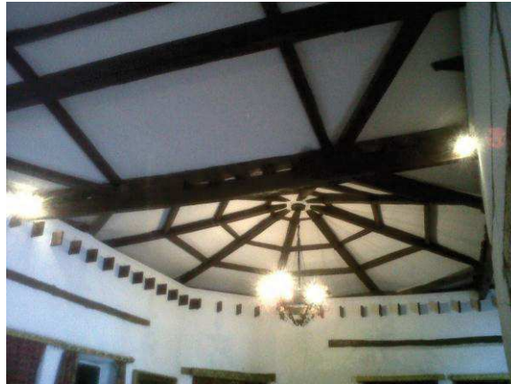
Figura 31. Detalle Cielo Raso
