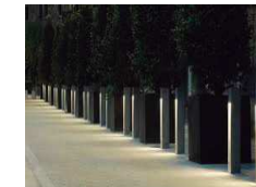
Luminarias bajas dentro del proyecto
