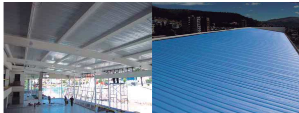
Figura 229. Cubierta Tomado de (kutermico, s.f) www.kubiec.com
