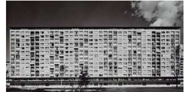
Figura 64. Grindelberg Hochhäuser Tomado de (Hamburg houchhaeuser) www.ansichtskarten-center.de
