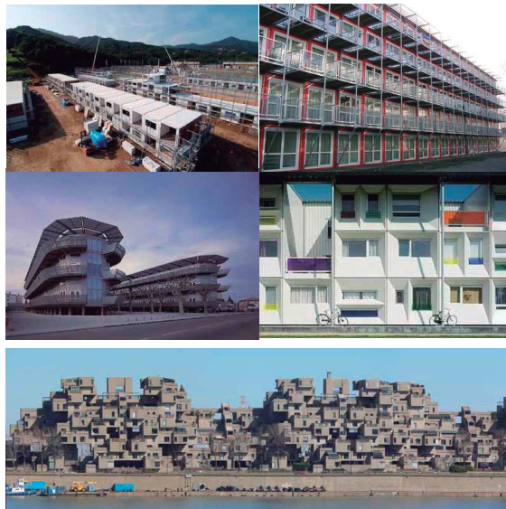
Figura 76. Arquitectura modular y prefabricable.
