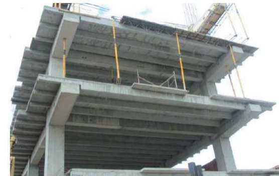
Figura 83. Estructura de hormigón prefabricada.
