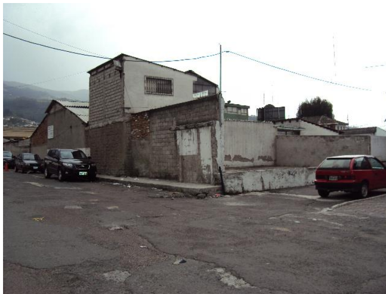
FIGURA 73. VIA DE ACCESO PRINCIPAL.
