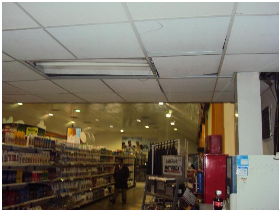
FIGURA 7. VISTA INTERIOR DEL SUPERMERCADO ÁREA DE PRODUCTOS PARA MANTENIMIENTO.
