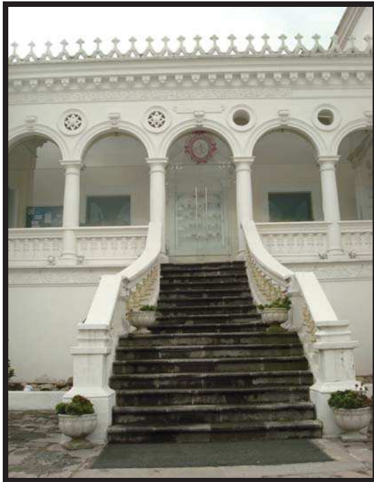
Figura 23. Ingreso principal Av. 6 de Diciembre Tomado de: Raitelli, 1999
