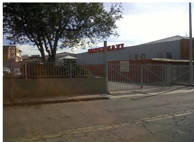
Figura 35. Fachada posterior vista desde Av. Homero Salas.
