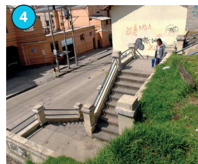
Figura 211. Vista escalintas de acceso
