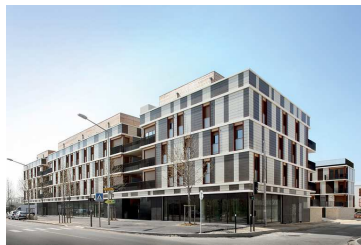
Figura 149. Conjunto de Viviendas Valenton Tomado de (Plataforma Arquitectura, s.f.) http://www.plataformaarquitectura.cl/ci/02-312366/conjunto-de-viviendas-valenton-gelin-lafon
