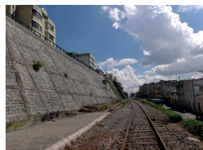
Figura 181. Talud que divide el Barrio Los Andes con el Barrio Sin Nombre 26
