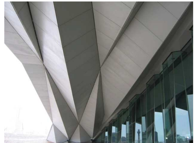
Figura 32. Cubierta. Terminal Yokohama
