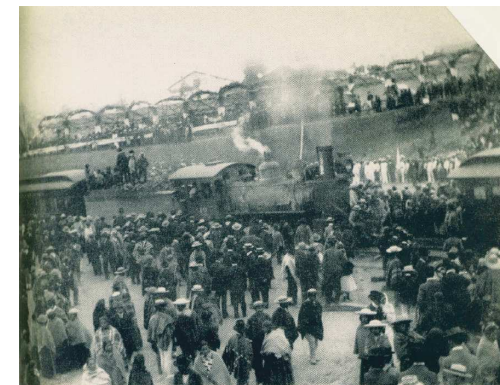
Figura 4. Estación provisional de Chimbacalle Tomado de (Sevilla et al., 2008, p. 265).
