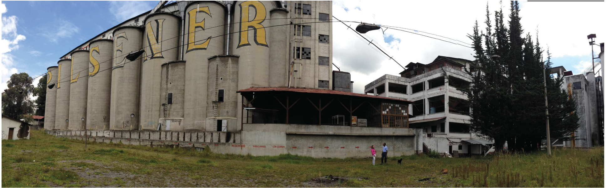
Figura 18. Panorámica Silos Pilsener
