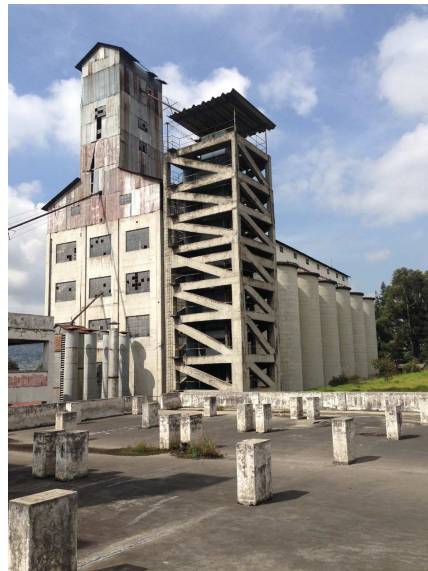
Figura 26. Torre de máquinas y elevador.
