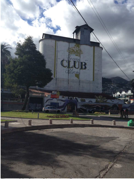
Figura 22. Silos Club, vista frontal
