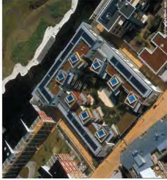
PANELES FOTOVOLTAICOS Y CUBIERTAS VERDES
