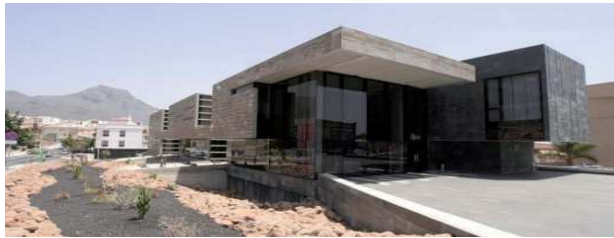
Figura 164. Cuartel de Policía de Adeje Tomado de (Plataforma Arquitectura, s.f.) www.plataformaarquitectura.cl
