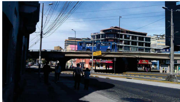
Figura 142. Aceras Puente del Guambra
