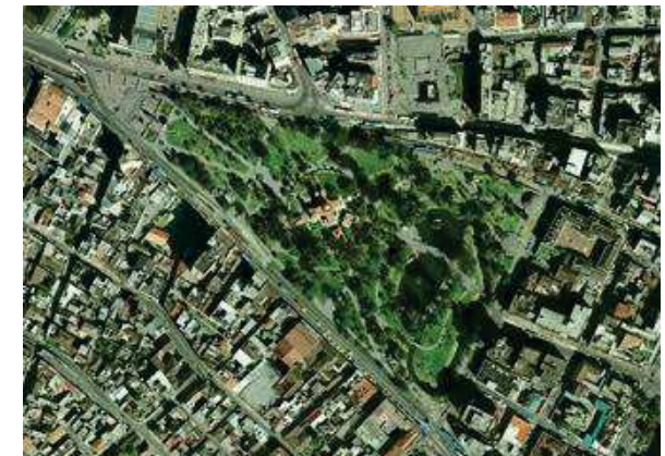
Figura 145. Parque La Alameda Tomado de Ing. Ramiro del Pozo, Cartotecnia S.A.
