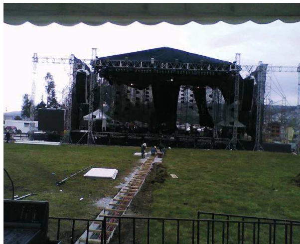
Figura 3.10. Cableado de la medusa enterrado en la feria de Quitumbe 2010.
