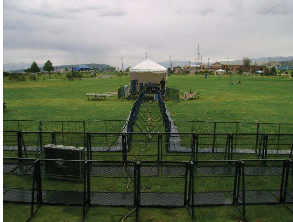
Figura 3.9. Cableado de la medusa aislado del público en el Quito fest 2010.
