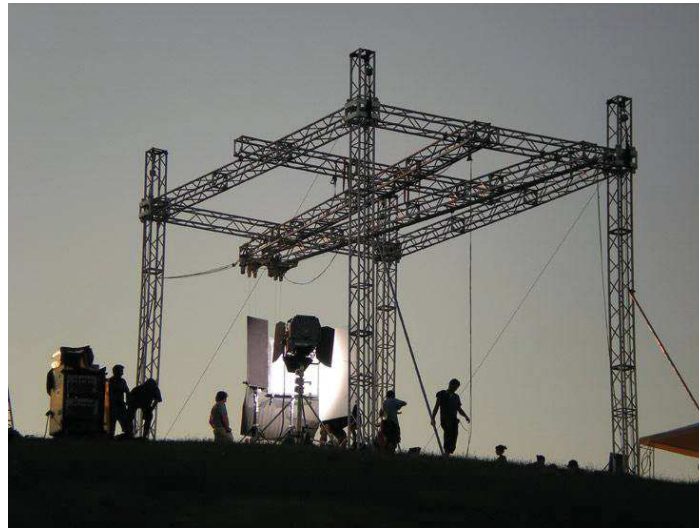
Figura 3.4. Estructura metálica levantada con fines de iluminación.
