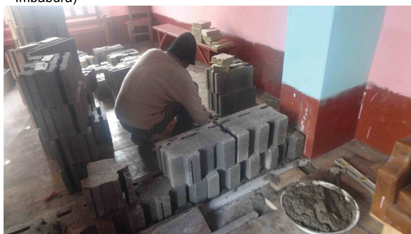
Anexo 53 Implementación de la Fábrica o Muro para la Medición
