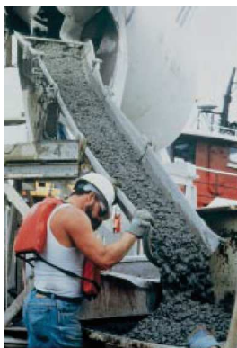
Figura 3. Trabajabilidad del Concreto Tomado de Kosmatka, et.al, (2004).Diseño y Control de Mezclas de Concreto, © Portland Cement Association.
