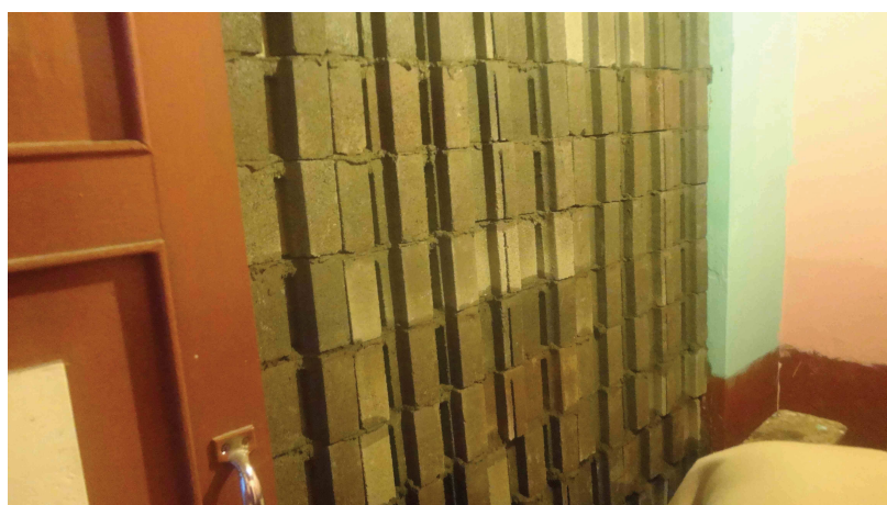
Anexo 55 Fábrica en Vista en la Sala de Recepción
