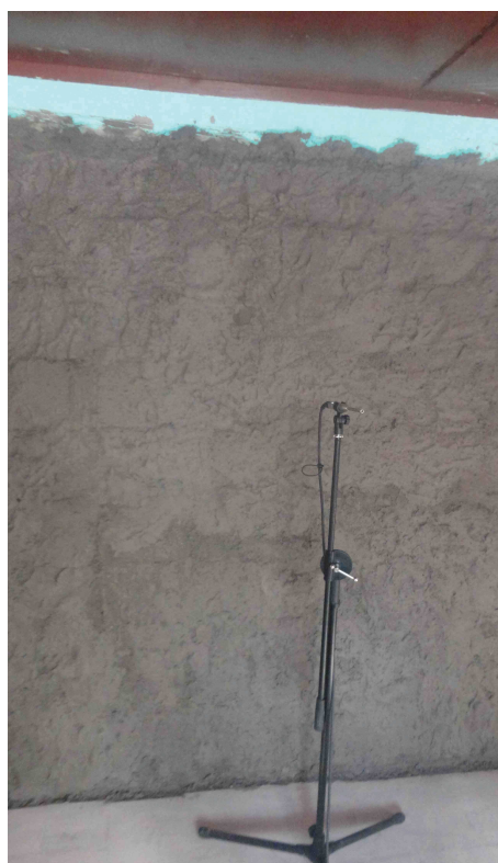
Anexo 57 Medición en la Sala Emisora
