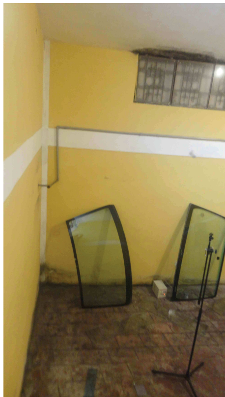
Anexo 38 Ubicación de los Equipos para la Medición de T60 2
