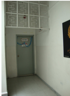
Estado actual de los repositorios.
