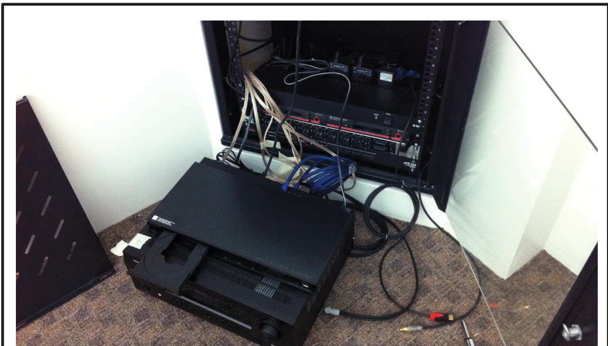
Figura 89. Instalación de equipos en el rack principal. 4/27/2011.
