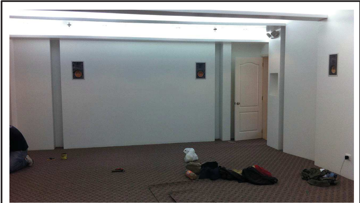
Figura 88. Instalación de alfombra. 4/25/2011.
