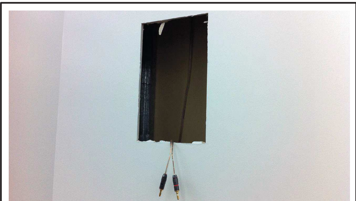
Figura 83. Instalación de cable de parlante y conectores THX. 4/20/2011.
