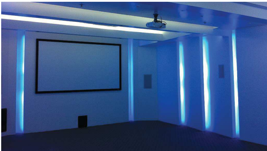
Figura 56. Construcción de paredes internas de la sala de proyección.
