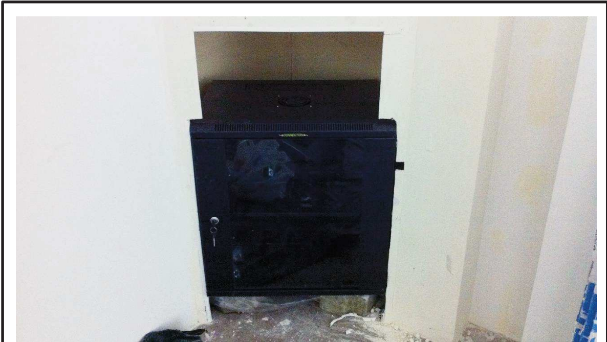
Figura 80. Instalación del rack de equipos. 4/11/2011.
