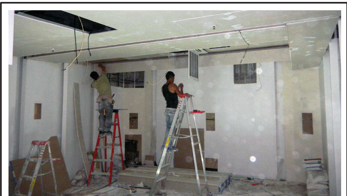
Figura 77. Inicio del ensamblaje del techo interno de la sala de video. 3/31/2011.
