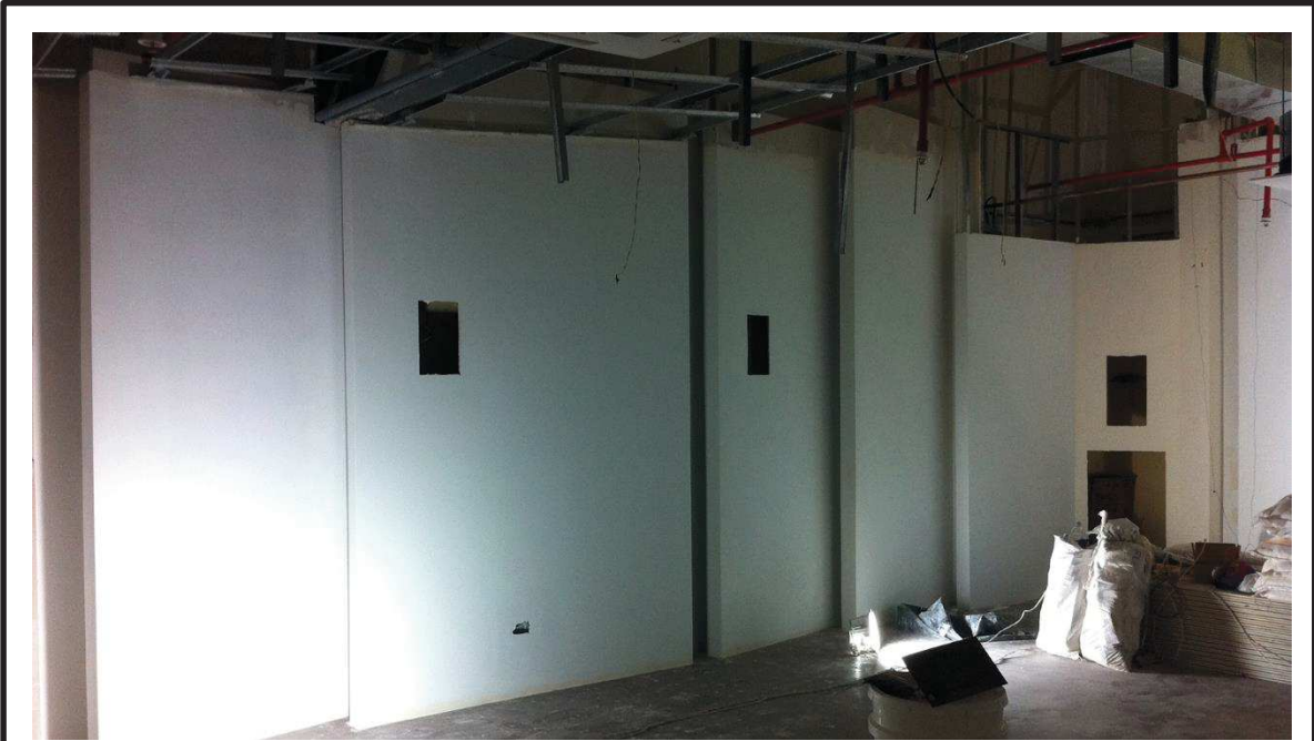
Figura 76. Finalización de las paredes internas de la sala de video. 2/17/2011
