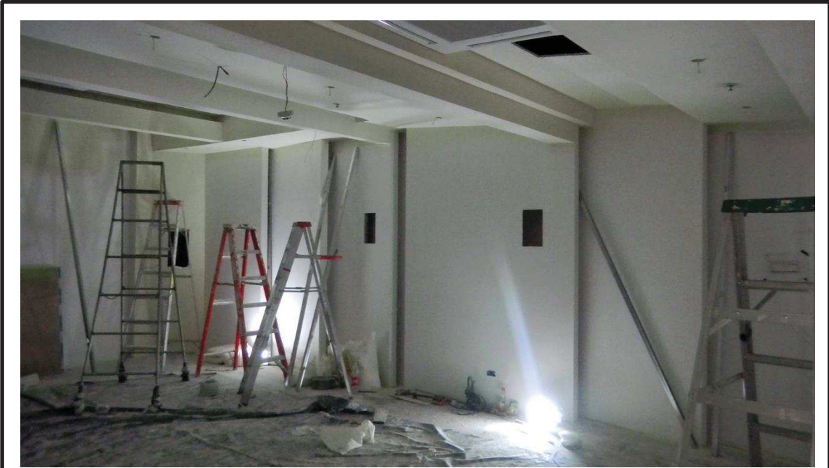
Figura 78. Pintura de paredes y techo internos de la sala de video. 4/6/2011.
