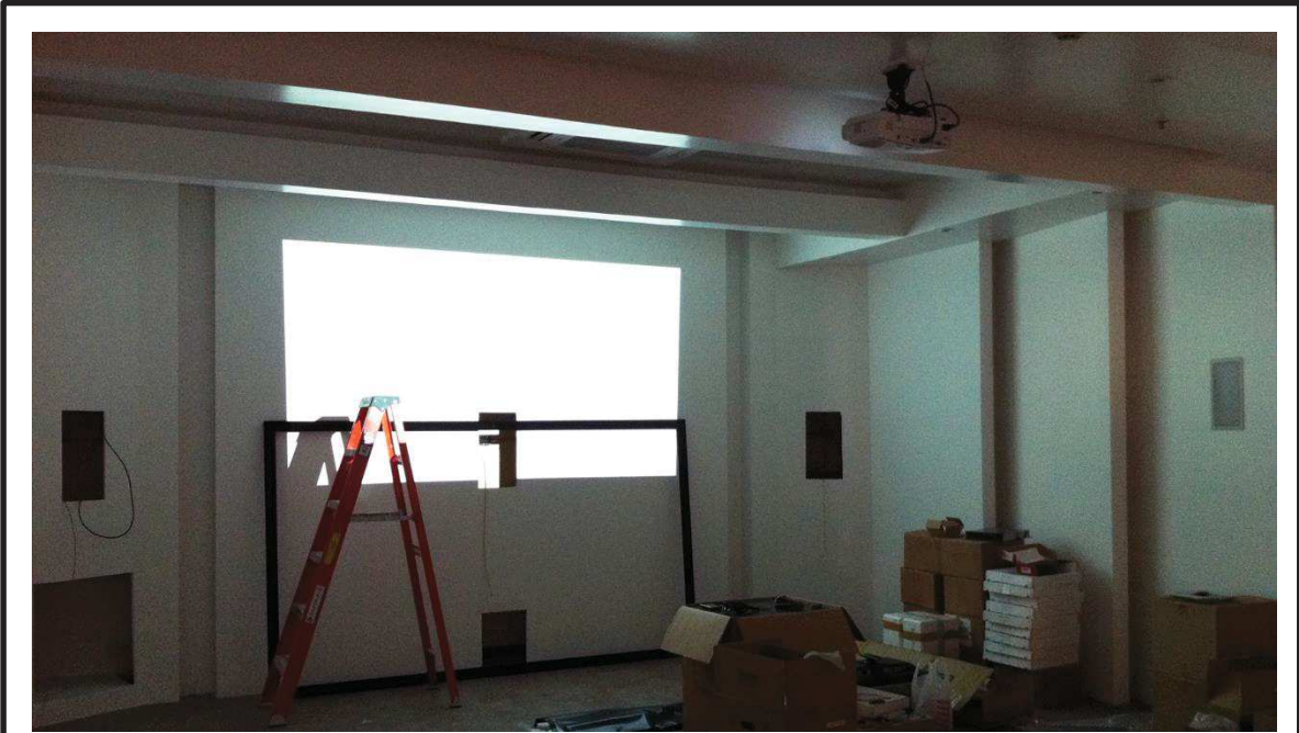
Figura 82. Instalación del proyector. 4/20/2011.
