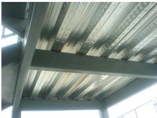
*Figura 13.* Deck, lámina metálica.
