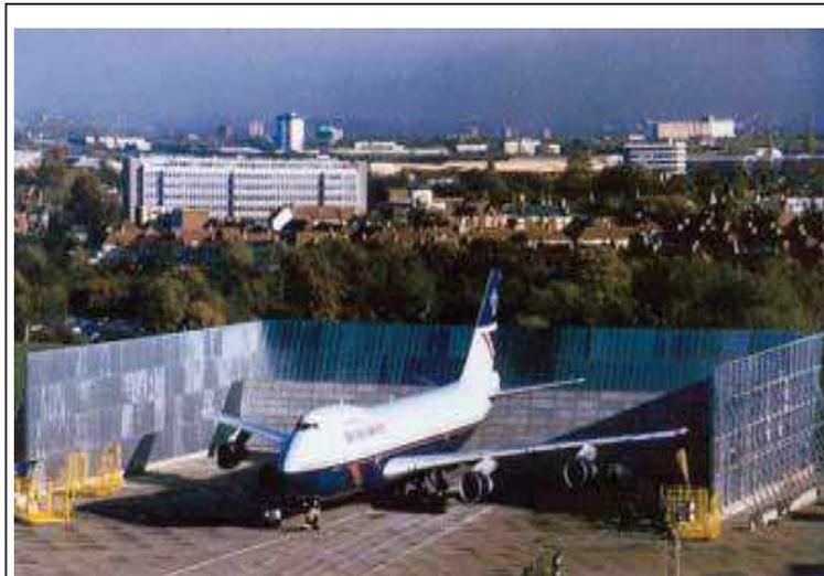
*Figura 40.* Modelos de barrera acústica en sector de calentamiento de turbinas, Stopson, (9 de septiembre de 2012). Pantallas, barreras y persianas acústicas. Recuperado de <http://www.stopson.com/webs/barreras.html>
