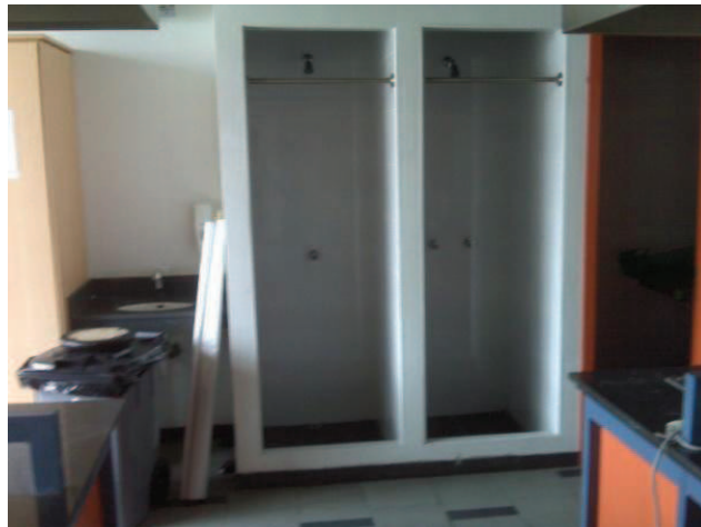
Figura 3.16 Duchas de emergencia laboratorio Química
