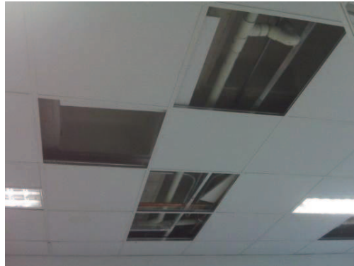
Figura 3.27 Techo laboratorio Física y Metrología
