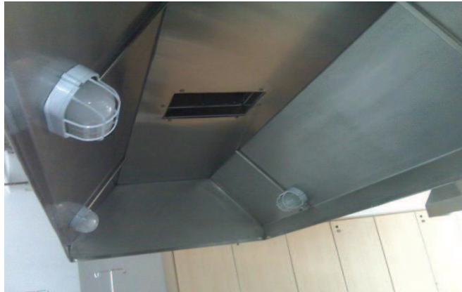
Figura 3.8 Extractor de humo y vapores laboratorio Biología
