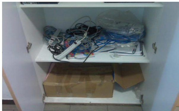
Figura 3.52 Almacenamiento materiales laboratorio Redes
