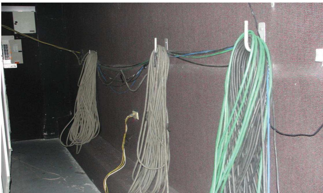
**EXPLICACIÓN:** Cableado tendido, por ahí circulan cables de audio, video, corriente eléctrica, y viene desde control *room*, *switcher*, cámaras
