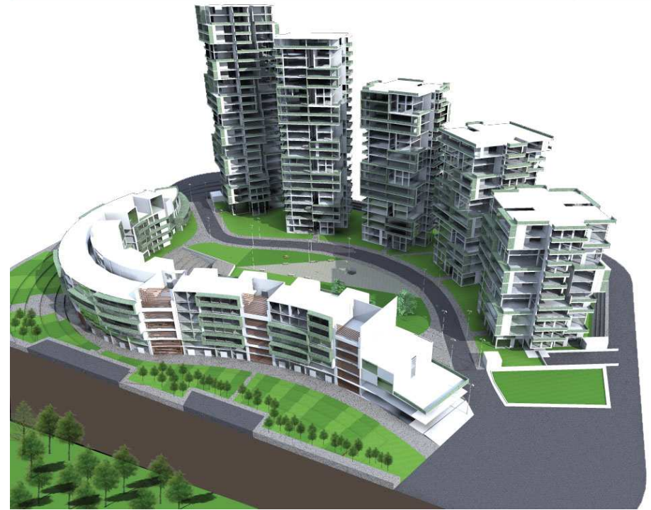
Imagen General del Proyecto desde la parte Norte
