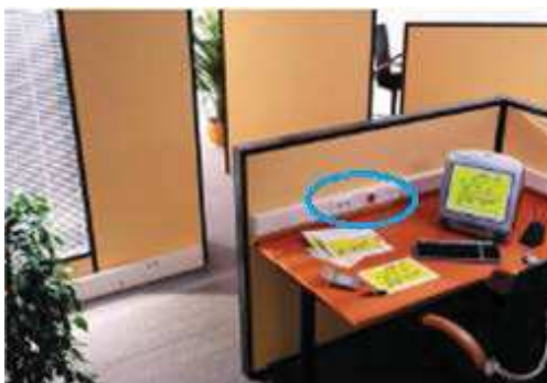
Figura 85 Salida de telecomunicación
