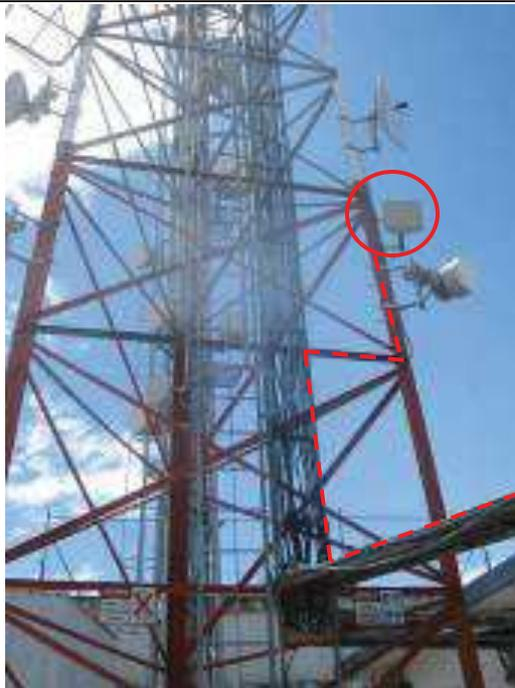
Figura 64. Instalación de la Odu en el nodo
