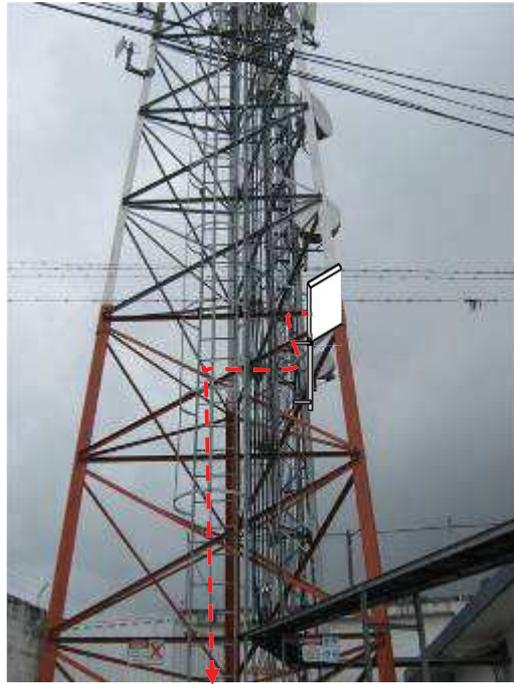
*Figura 52.* Ubicación de la antena y recorrido del externo del cable
