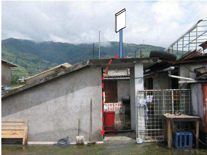
*Figura 53.* Ubicación de la antena y recorrido del externo del cable
