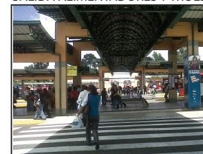
PASARELA DE DISTRIBUCIÓN.
