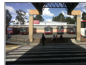
PARQUEADEROS ECOVÍA Y ALIMENTADORES.
