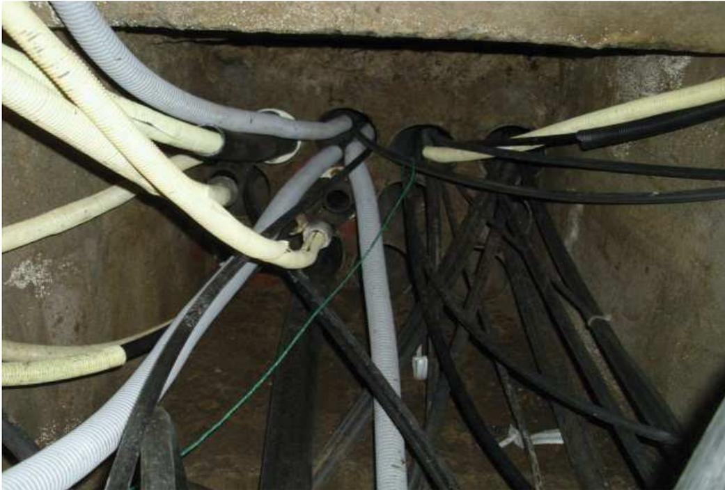
**Figura 44.** Ductos en la canalización en cámaras telefónicas llenos.
