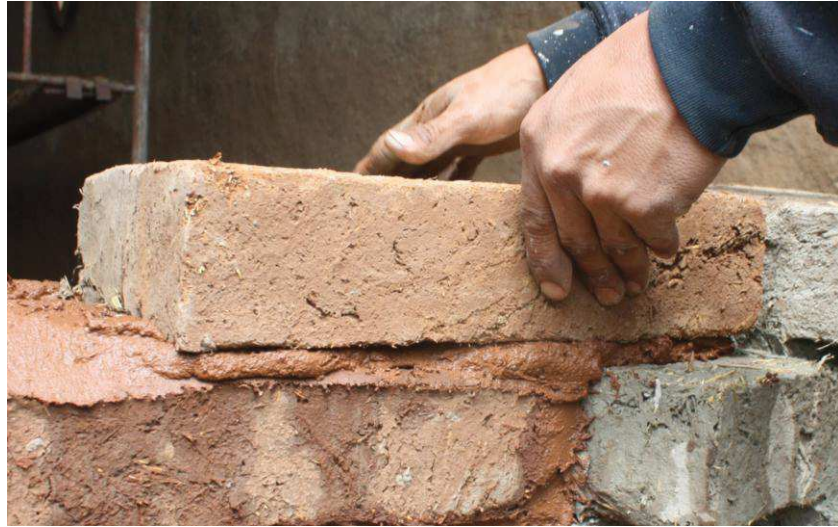
Figura 16. Montaje de los ladrillos de adobe.
