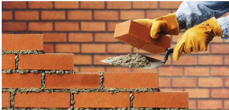
Figura 20. Montaje de pared de ladrillo común. Tomado de Flas ProInteg. (s.f.)
