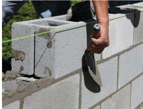
Figura 18. Montaje de pared de bloque Tomado de (Silver Lake Media Group, 2008)
