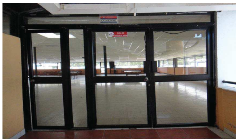
Figura 18. Fotografía de la puerta de la sala.
