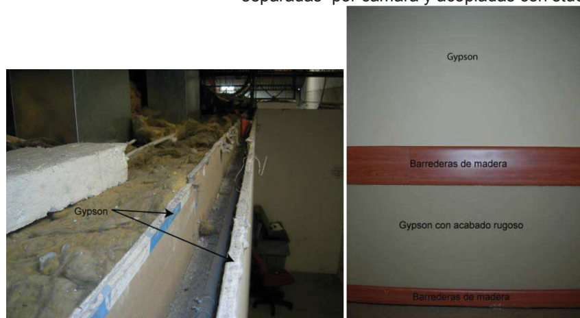
Figura 3.13 Descripción de la superficie de las paredes dentro de las salas, además de las placas de gypsum separadas por cámara y acopladas con stud.
