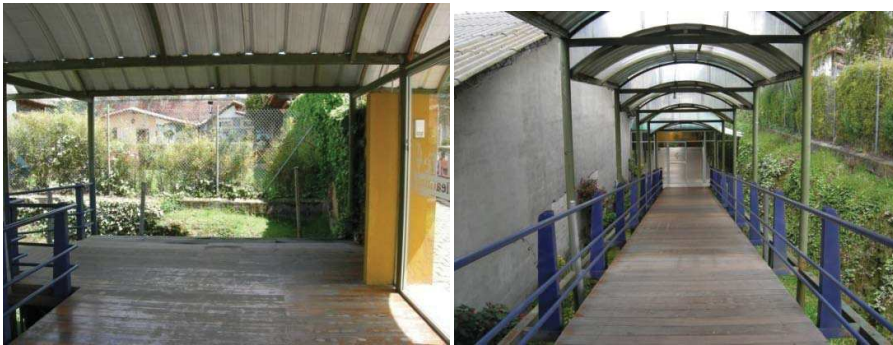
Figura 3.4 Rampa de acceso a las salas y oficinas
