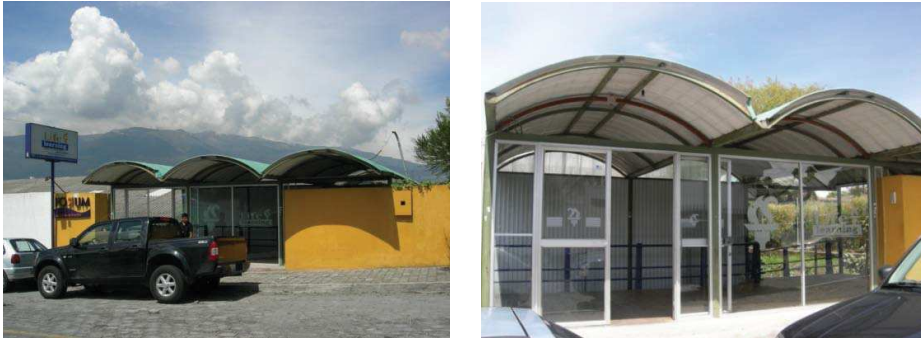
Figura 3.3 Entrada a las instalaciones
