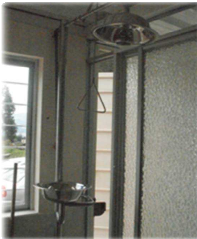
Fotografía 5.20 Sistema de lavado de ojos
