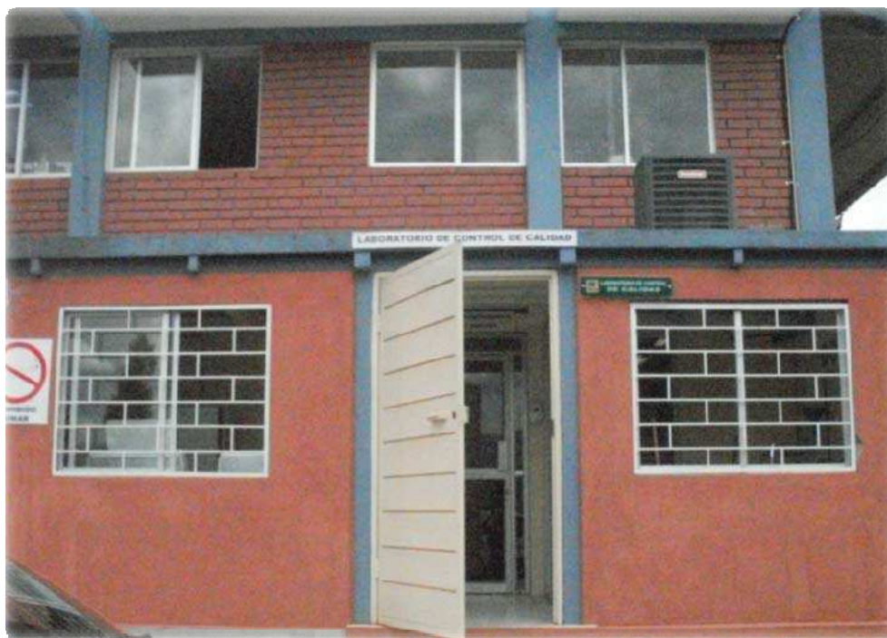
Fotografía 5.25 Laboratorio de control de calidad 2011
