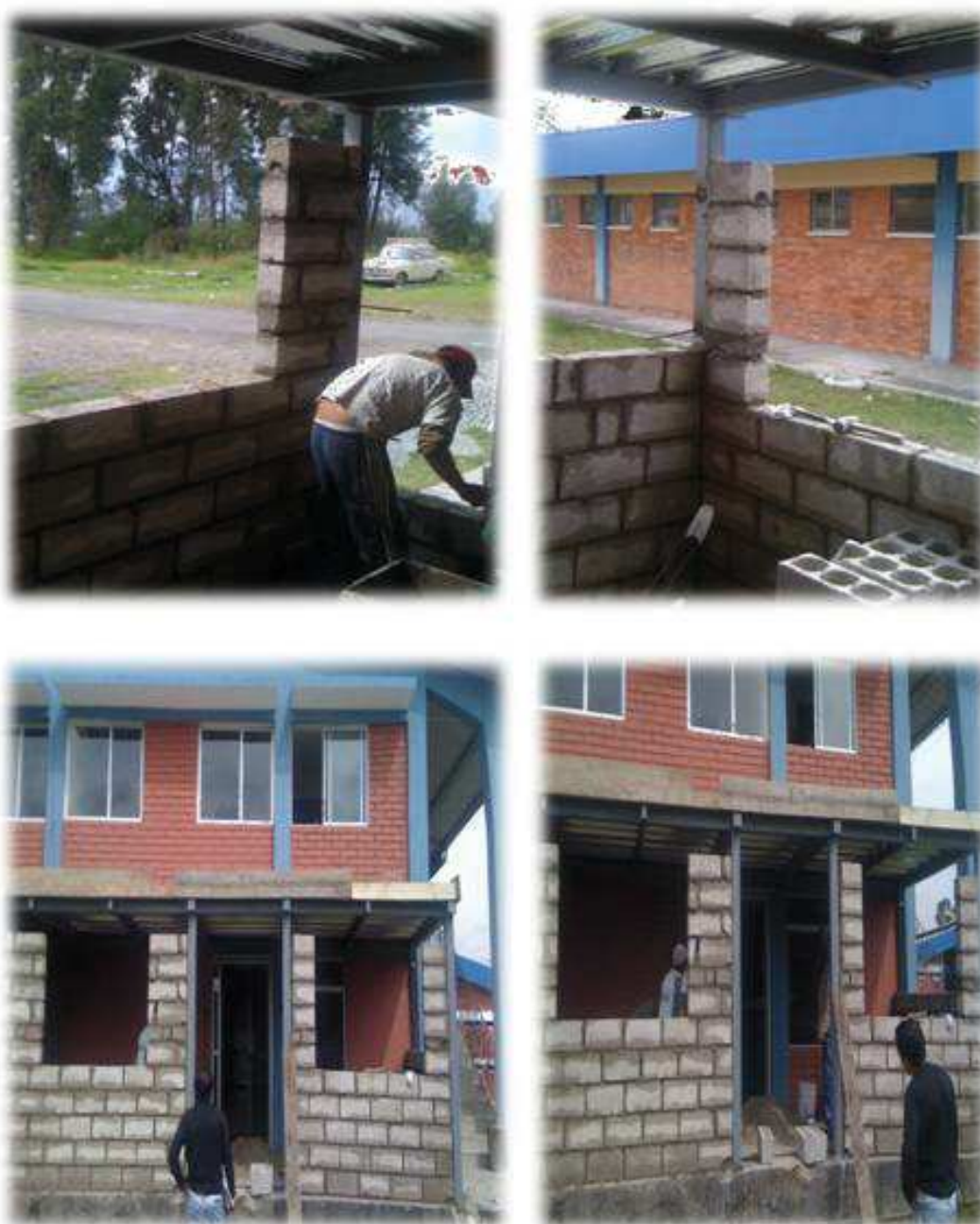
Fotografía 5.16 Adecuación de área de laboratorio
