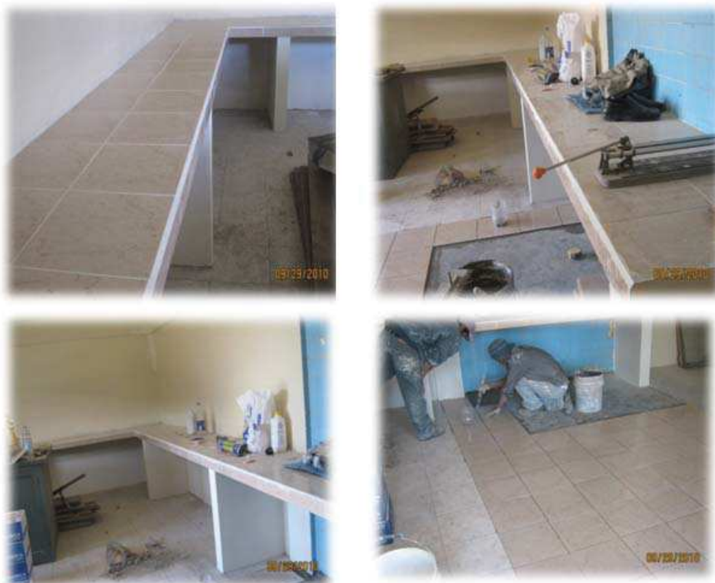
Fotografía 5.14 Readecuación del laboratorio de control de calidad
